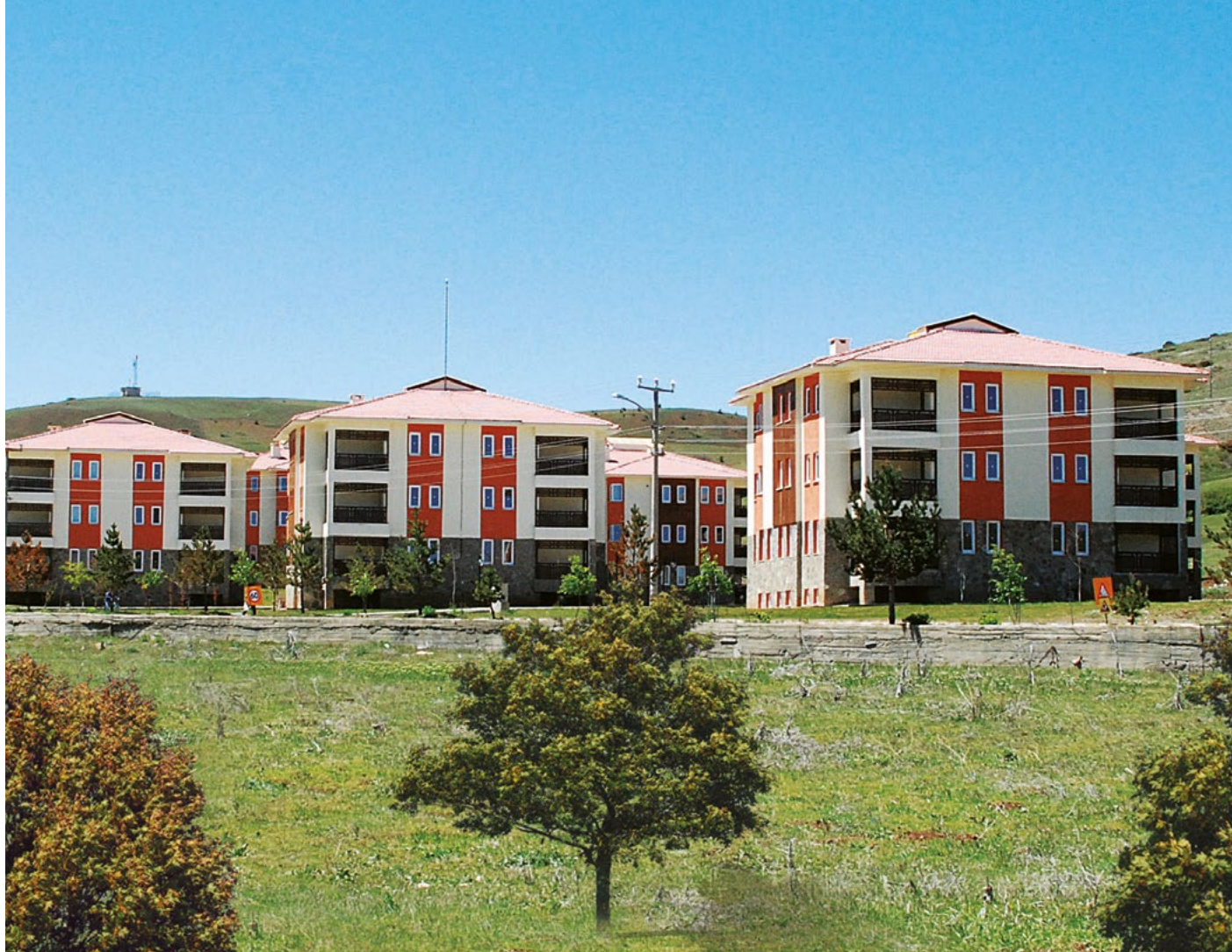
REFAHİYE SOSYAL KONUT UYGULAMASI SOCIAL HOUSING PROJECT
